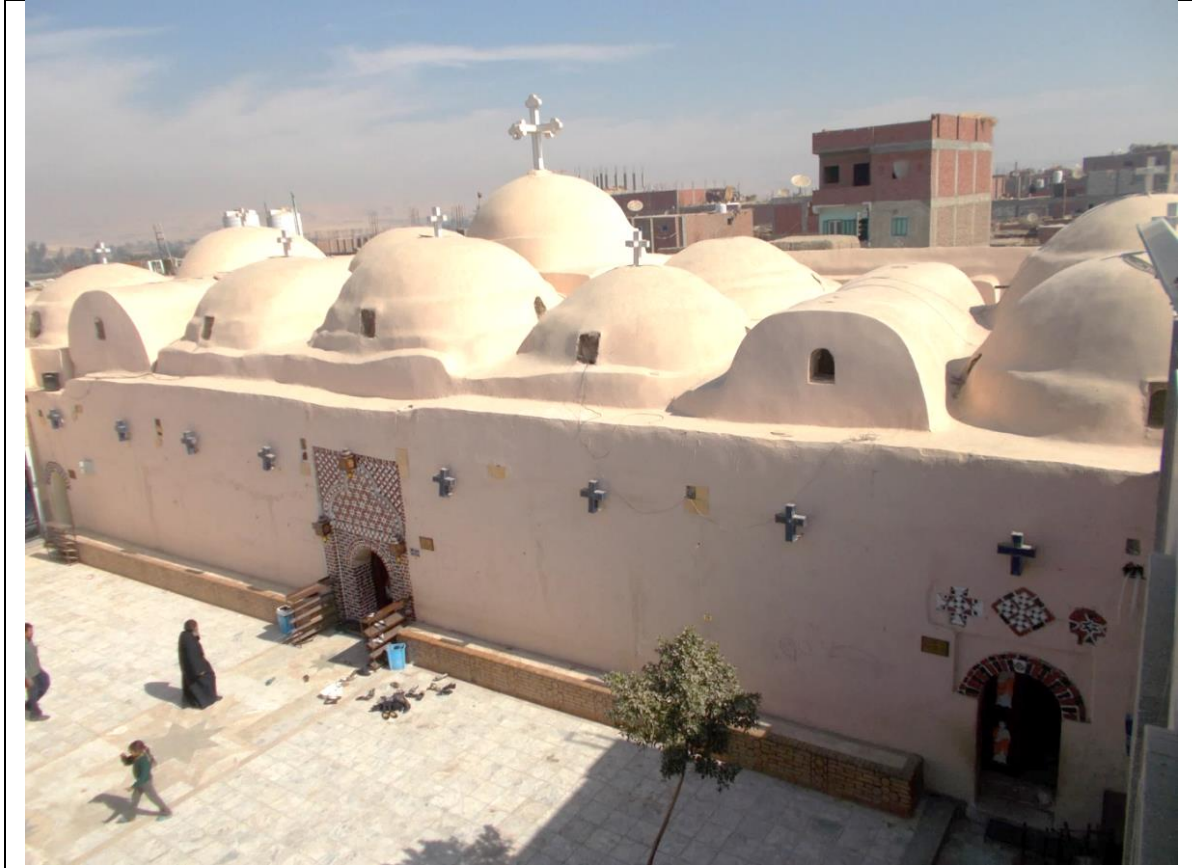
(لوحة ٢١) الطوب المنجور يزين فتحتا المدخلين الصغيرين في طرفي واجهة كنيسة ماري جرجس بالعيساوية
