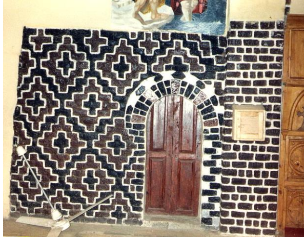
(لوحة ٢٤) واجهة الحجر التي تقع شمال الهيكل الشمالي المزخرفة بالطوب المنجور بكنيسة ماري جرجس
