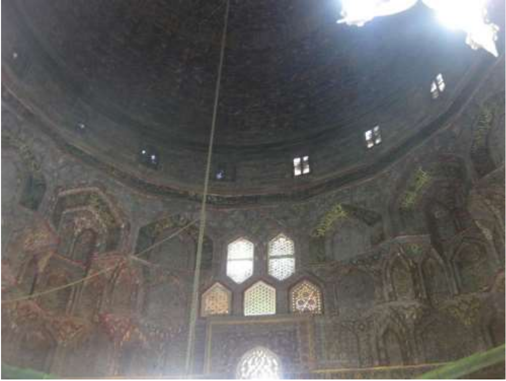
شكل (تفصيل لمناطق الانتقال الخشبية واواسط مناطق الانتقال ( النوافذ الجصية ) وباطن القبة وزخرفتها
