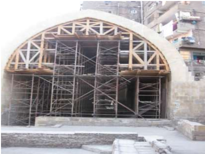
شكل ( ) تفصيل للعقد المدبب الذي يعلو واجهة الايوان الشمالي الغربي للمدرسة الكاملية
