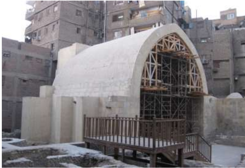
شكل ( ) تفصيل لسقف الايوان الشمالي الغربي المتبقى من الايوان الشمالي الغربي ويظهر على شكل عقد مدبب ويتشابه مع قبو مدرسة السادات الثعالبة بقرافة الامام الشافعي
