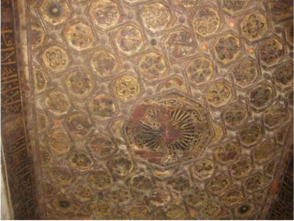
شكل ( ) سقف خشبي عبارة عن قصب وحفاق خشبية بها زخارف نباتية
