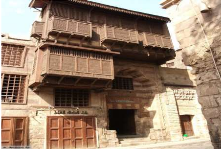
شكل ( ) تفصيل الواجهة الجنوبية الشرقية ويظهر بها النظام المشهر المبني به الواجهة الحجرية والقمرية اعلى المحراب والشرفات اعلى الواجهة
