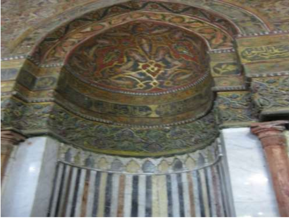
شكل ( ) المحراب الرئيسي لضريح قبة الامام الشافعي وهو واحد من المحاريب الثلاثة الزخرفية بالواجهة الجنوبية الشرقية وبه إضافات من العصر المملوكي تتمثل في الأشرطة الرخامية الرأسية
