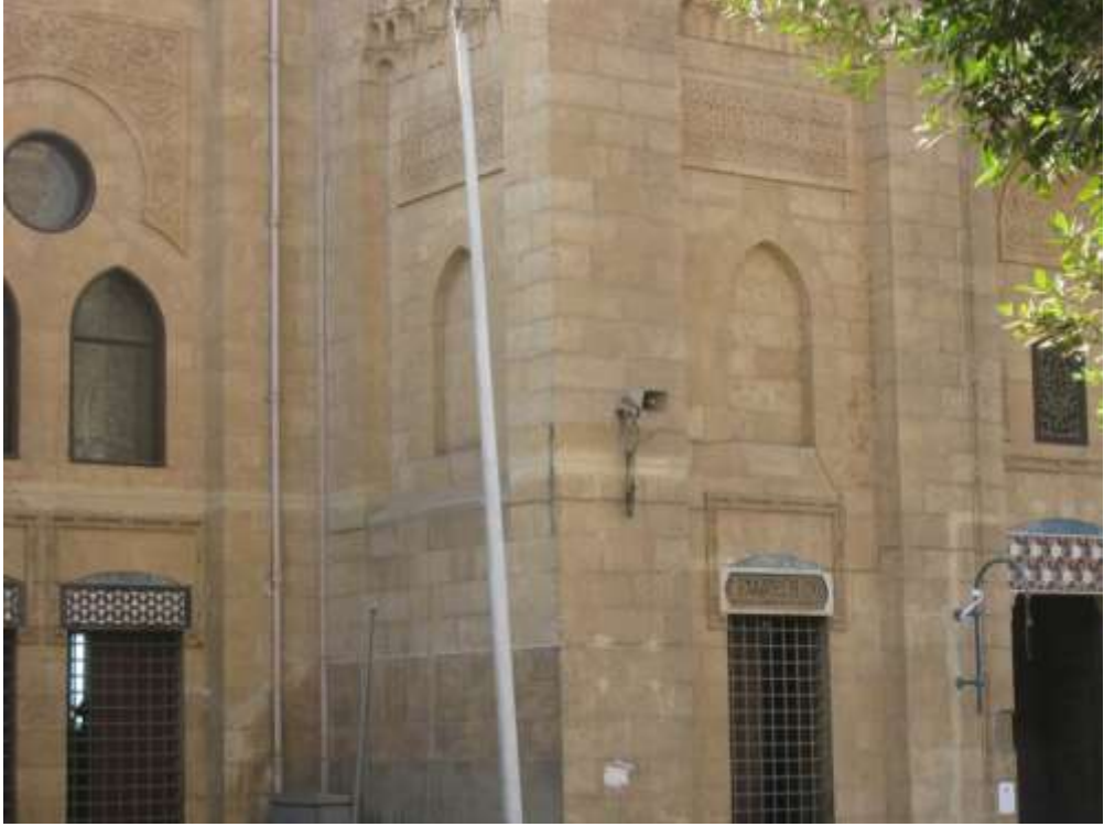
شكل ( ) الواجهة الشمالية الشرقية بجامعة الامير محمد توفيق يطل على شارع الاشرف
