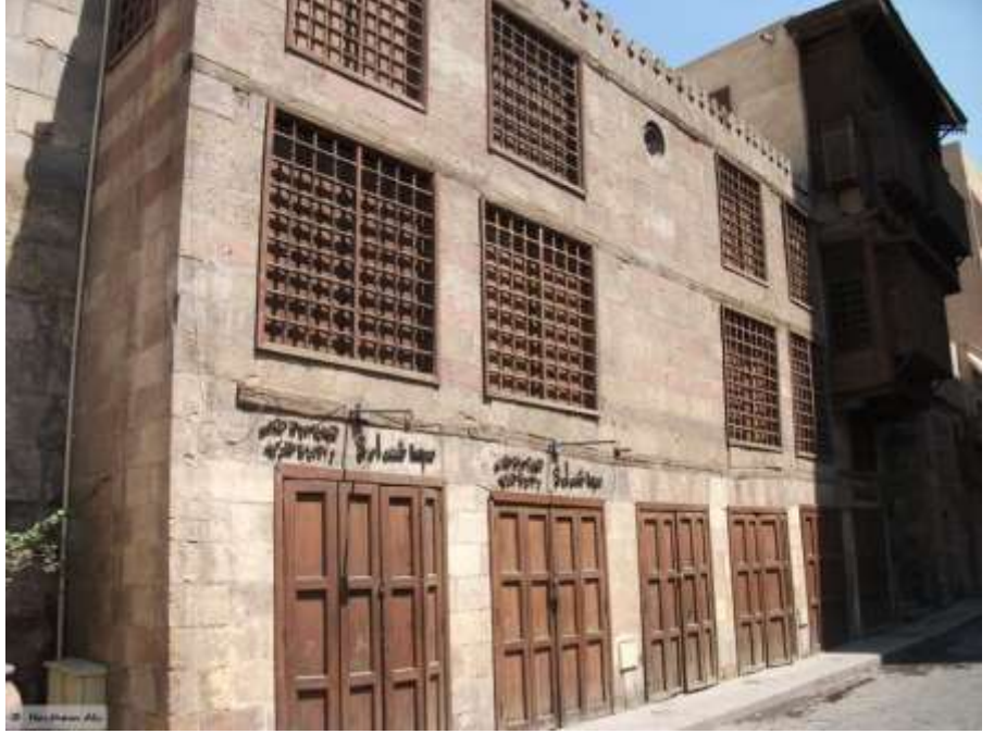
شكل ( ) تفصيل للواجهة الجنوبية الشرقية للمدرسة الكاملية ويظهر بها المسجد المعلق واسفلها اربع حوانيت
