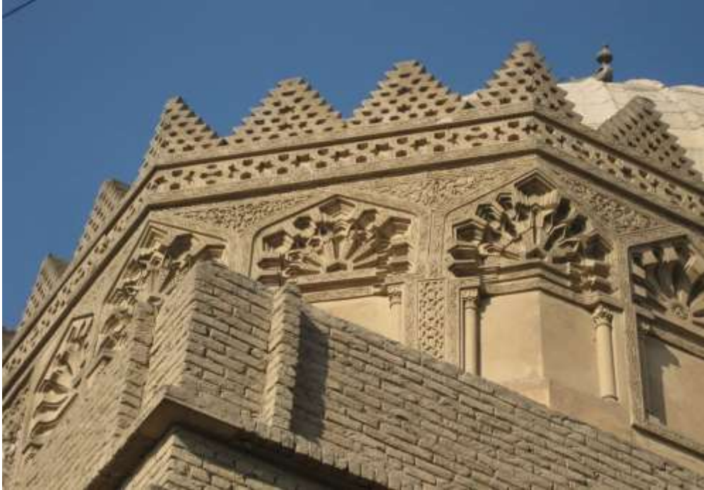
شكل ( ) زخرفة المئمن الخارجي بمئمن قبة الشافعي الخارجي بالدخلات الرأسية متوجة بعقود منكسرة مشعة على الطراز الأيوبي محمولة على أعمدة رشيقة مئمنة ويتوج المئمن شرافات مسننة مفرغة
