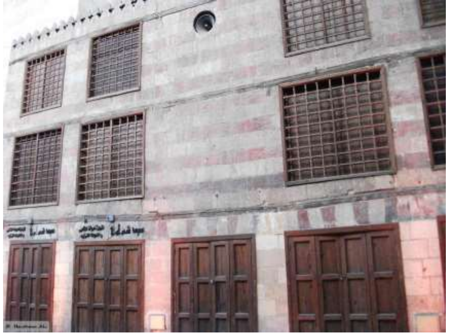
شكل ( ) تفصيل الواجهة الجنوبية الشرقية ويظهر بها النظام المشهر المبني به الواجهة الحجرية والقمرية اعلى المحراب والشرفات اعلى الواجهة
