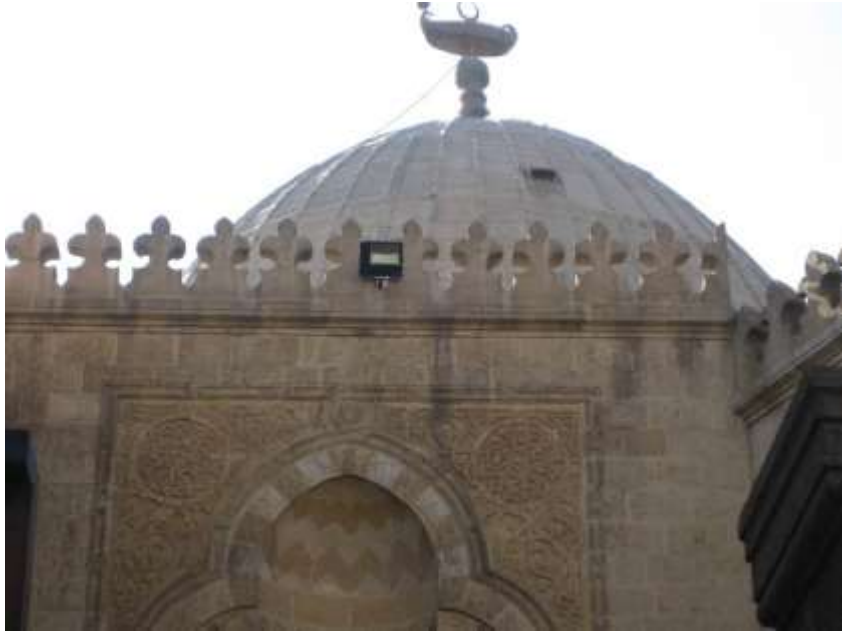
شكل ( ) قبة الامام الشافعي من الخارج ويظهر بها الواح الرصاص والقائم نحاسي والعشاري والسلسلة الحديدية التي تتدل منها
