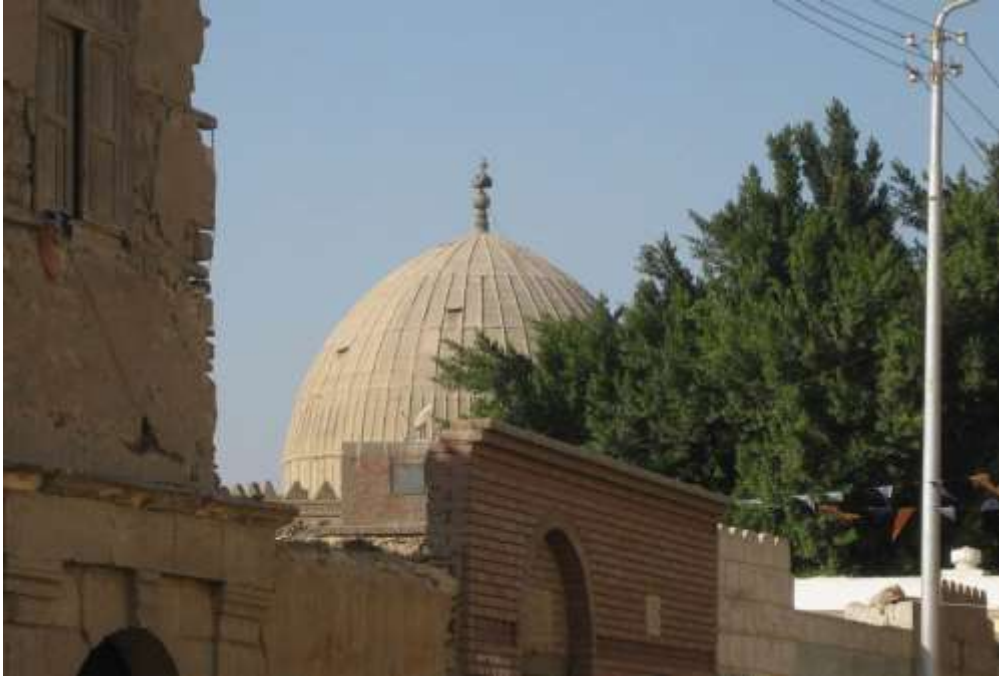
شكل ( ) قبة الامام الشافعي من الخارج ويظهر بها الواح الرصاص والقائم نحاسي والعشاري والسلسلة الحديدية التي تتدل منها
