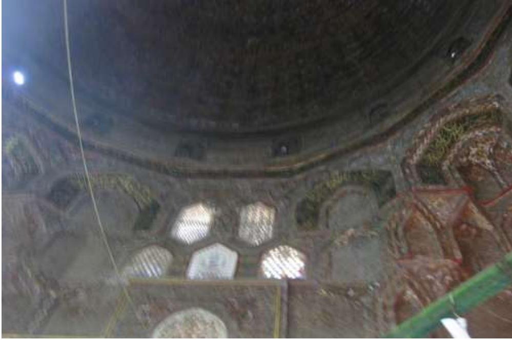
تفصيل لمناطق الانتقال الخشبية واواسط مناطق الانتقال ( النوافذ الجصية ) وباطن القبة وزخرفتها .
