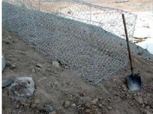
عمليات التثبيت باستخدام الجايون Gabion (رص الأحجار داخل الشبك المضلع).
