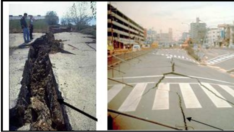
نماذج من التشققات التي تحدثها الزلازل
