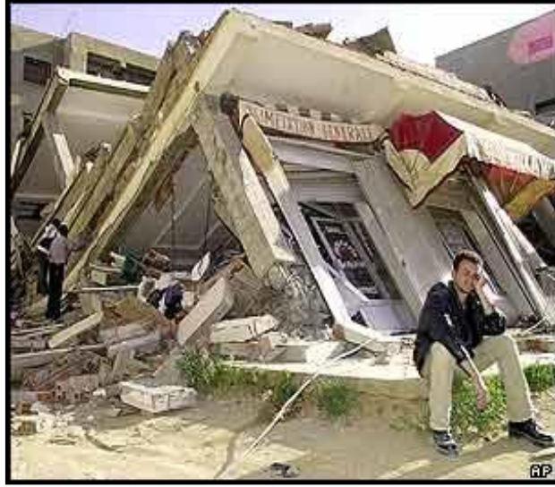
انهيار المنازل في زلزال بومرداس بالجزائر
