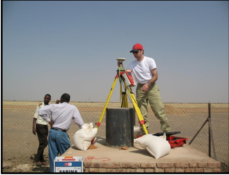
صورة (٢٢) تحديد إحداثيات نقاط الربط الأرضية بأجهزة GPS
